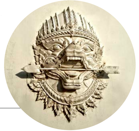
ป้ายปูนตราหนุมานคาบศรหลังซ่อมแซม
